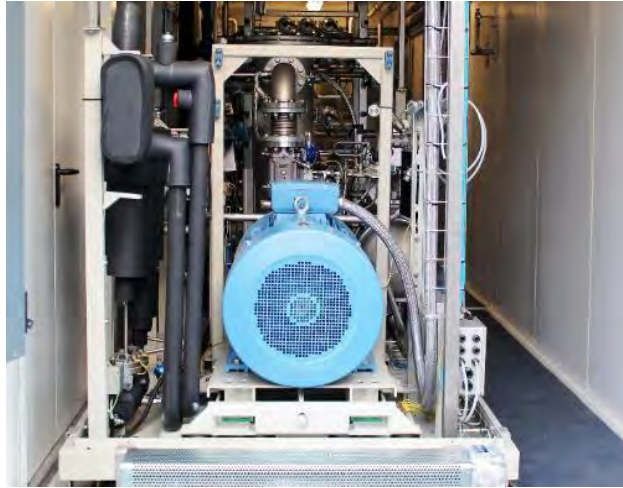
Ilustración 9.- Compresor de biogás de una instalación de upgrading.
